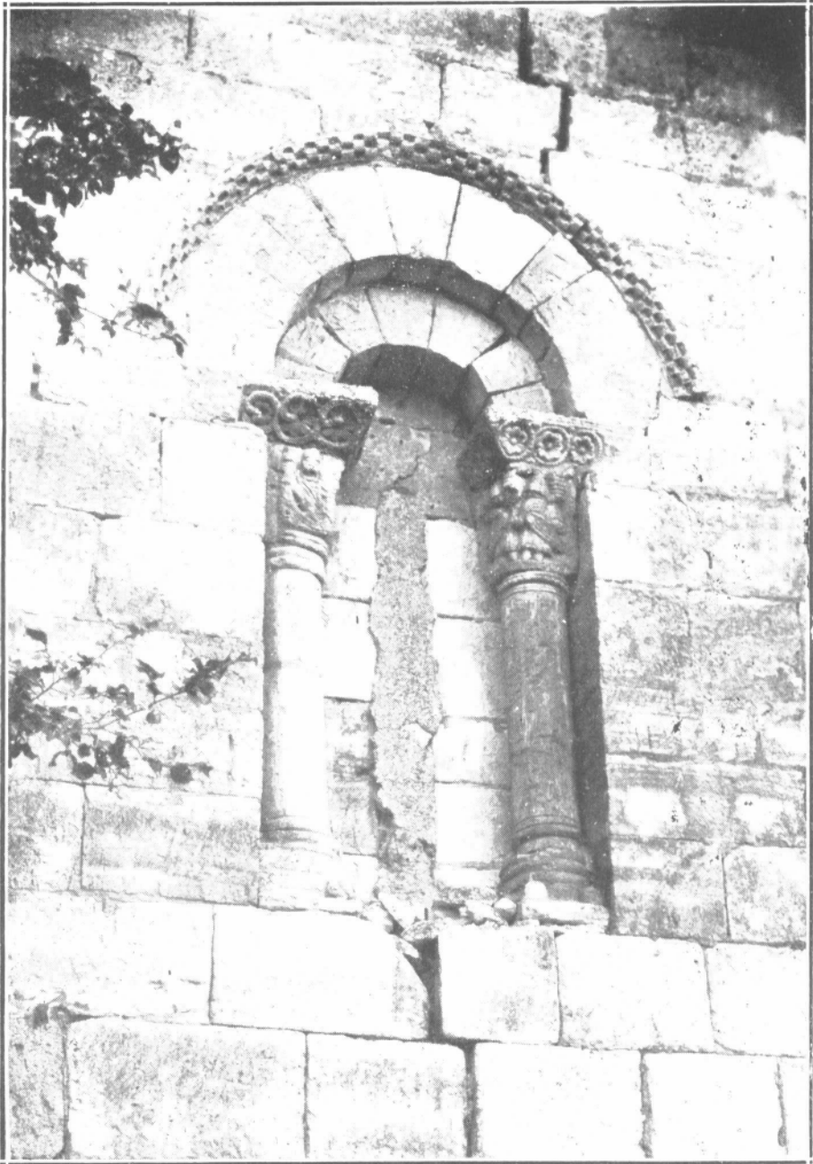
ESPINOSA DE CERRATO.-- Ventanal absidal.
