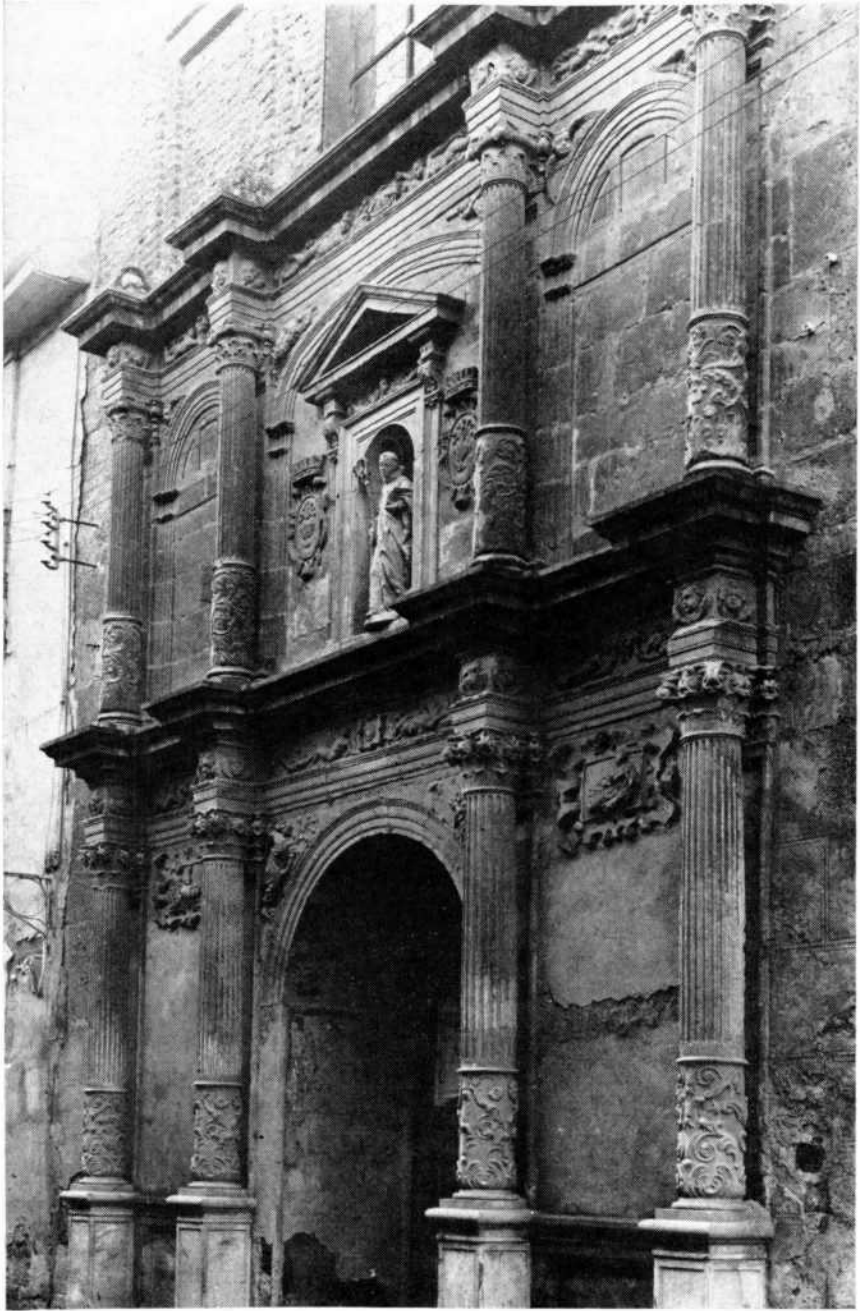
1 (bis).—Fachada de la iglesia (1598-1605).
