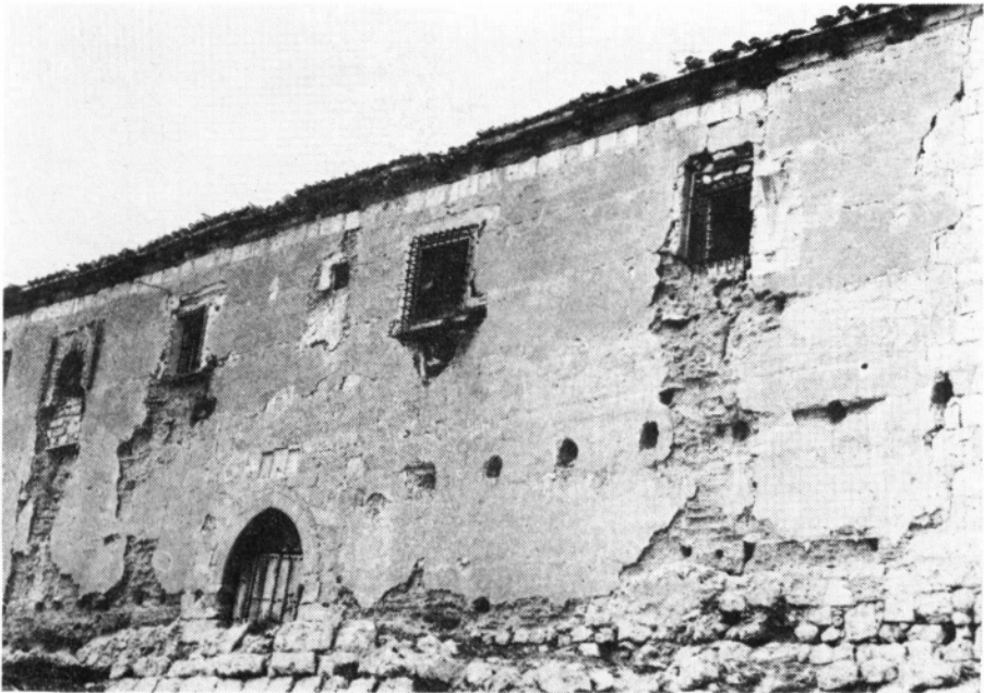
Lámina V. — CASTRILLO DE DON JUAN. Palacio-fortaleza de los Delgadillo. 1. Can de proa en el patio. 2. Ventana con pieza aprovechada de una bóveda de crucería. 3. Detalle de la fachada Sur.
