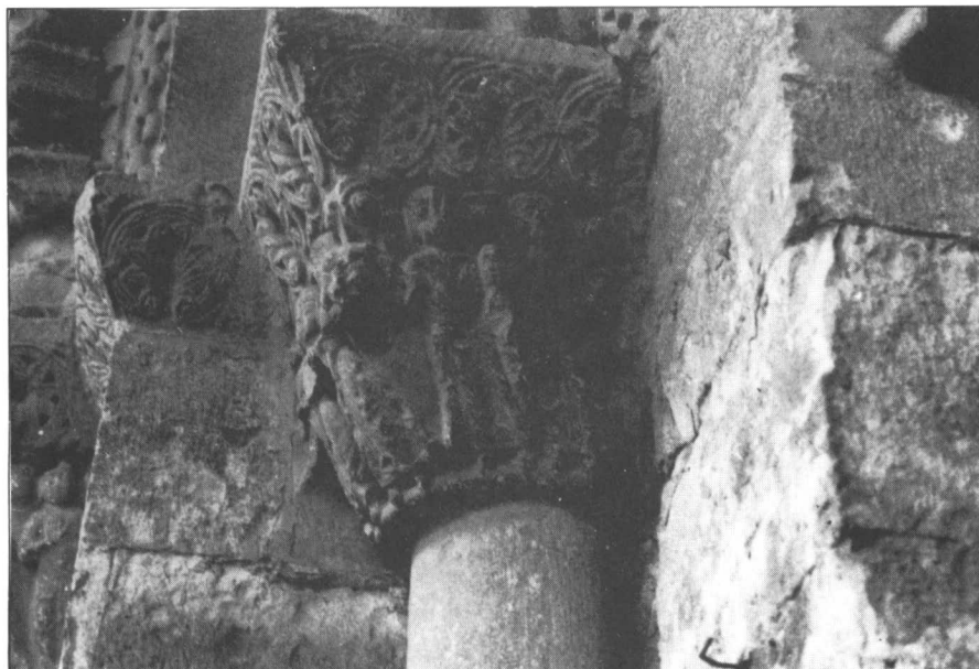
Lámina 4. Capitel interior izquierdo. Cara lateral.
