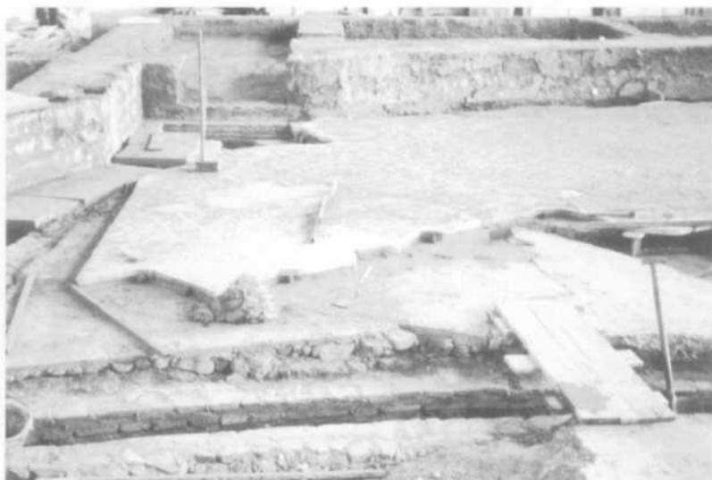
Foto M: Fase de la recolocación. Pueden observarse los nuevos *bipedeles* de la *suspensura*
