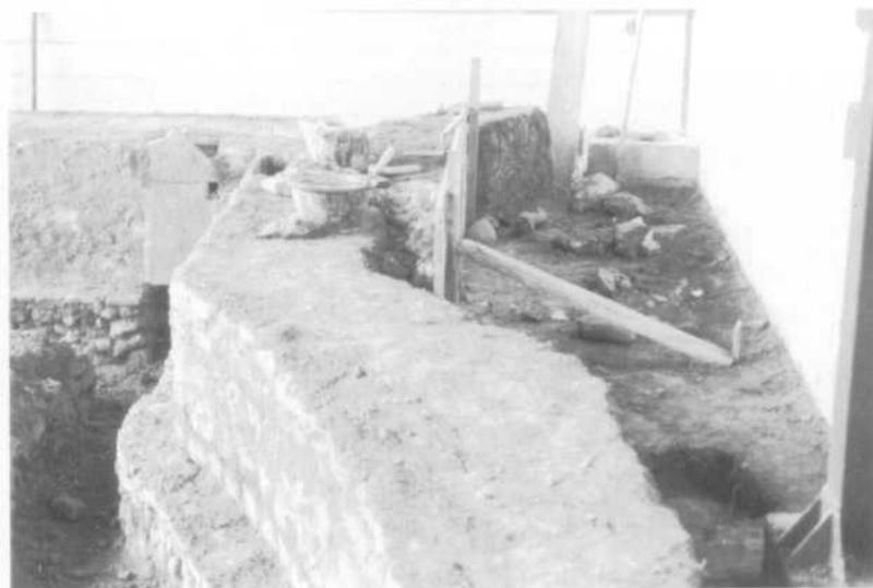
Foto F: Fase del recrecimiento de los muros. Puede apreciarse la disposición de las *tegulae* en una de las chimeneas.
