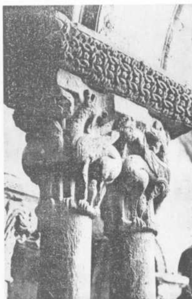
Foto 18.- Capiteles del Claustro de Santa María la Real, en Aguilar de Campoo. Antes de su restauración.
