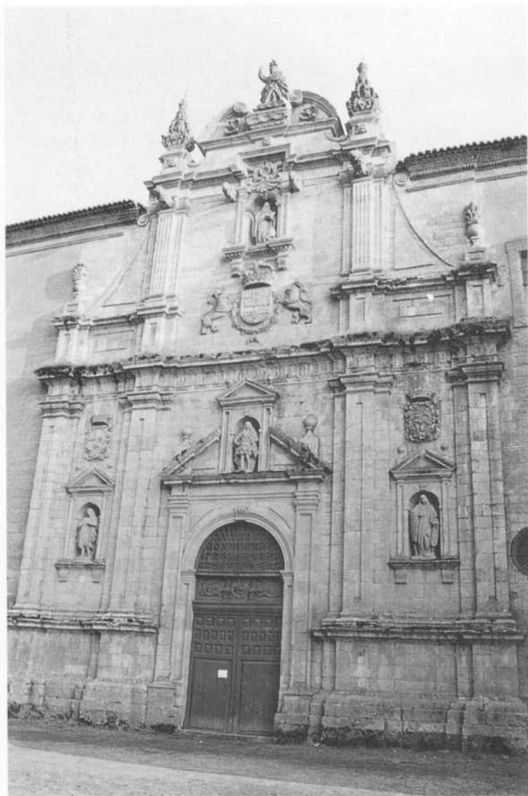
Foto 9.- Iglesia del Monasterio de San Zoilo. Vista exterior. Estado actual. Carrión de los Condes.
