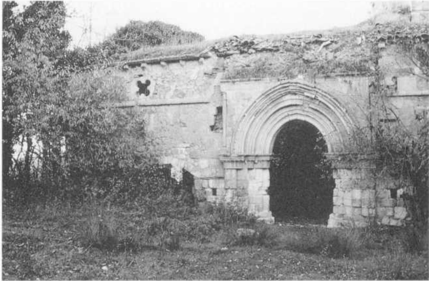
Foto 1.- Priorato de San Salvador del Nogal, en Nogal de las Huertas. Estado actual.
