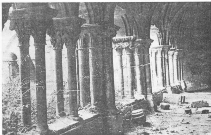
Foto 17.- Claustro de Santa María la Real, en Aguilar de Campoo. Antes de su restauración.
