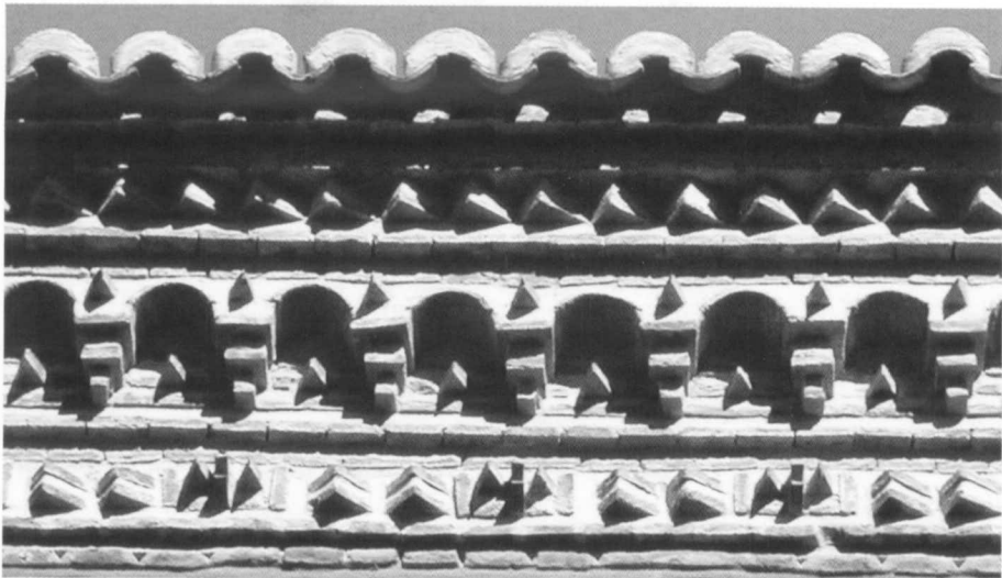
Lám 5.- Detalle del alero del Palacio de los Aguado Pardo (Casa Junco).
