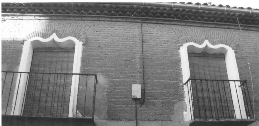
Lám. 10.- Balconadas en Villada
