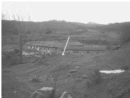
Fig.12: Solar que ocupaba la venta de Santiago, y edificios actuales de la venta Urbaneja.
