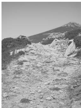
Fig. 25: Calzada del Arauz. Tramo esculpido en roca.
