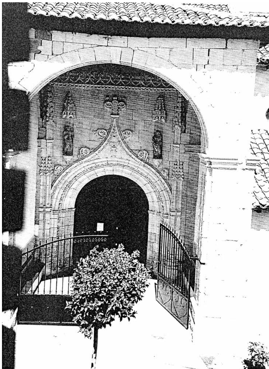
Pórtico de la iglesia.
