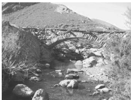
Fig. 20: Puente de Riofrío.
