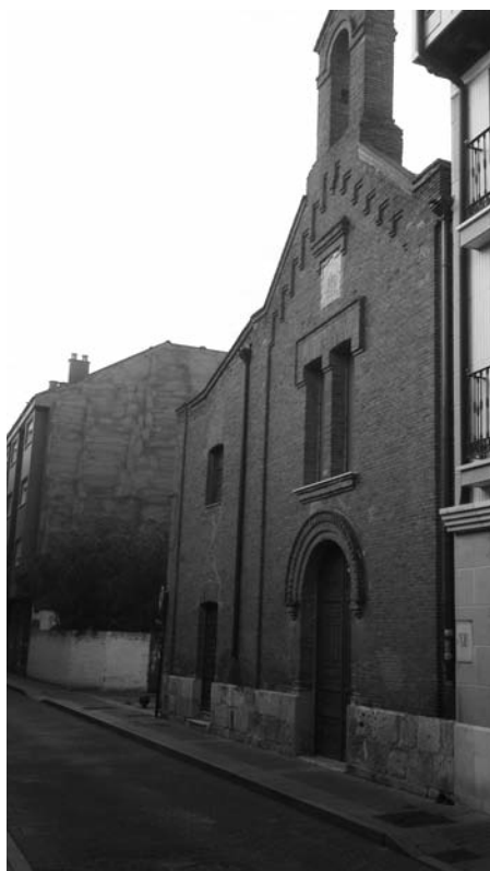
Sacramental de San Miguel. Fachada Oeste.
