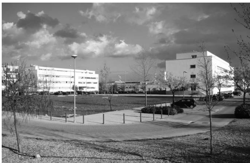
Foto 2.- Los edificios departamentales y parcela Bloque IV. Foto: E. Delgado, 2011.
