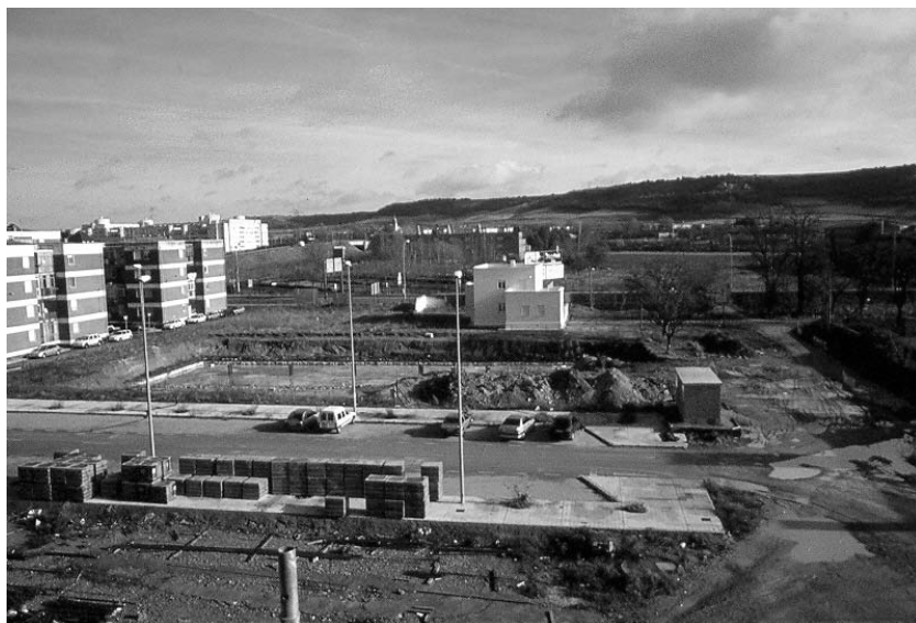
Foto 5.- Edificio E en cimientos y chalet Administración: E. Delgado, Enero de 2001.
