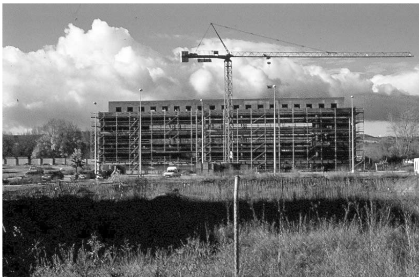
Foto 1.- El edificio D en construcción. Foto: E. Delgado, Octubre de 2000.
