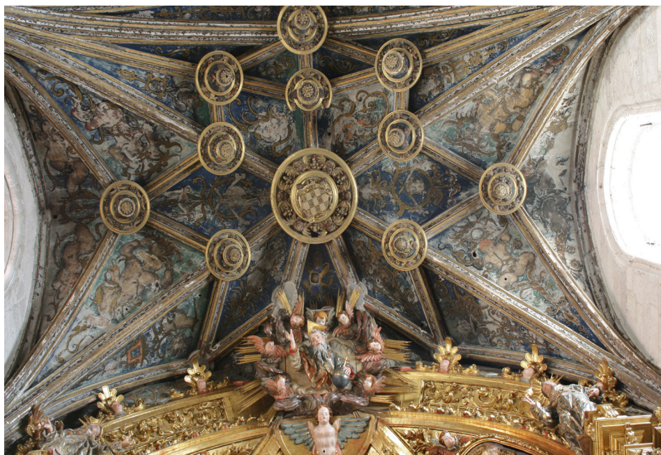
Detalle de la bóveda del primer tramo de la capilla mayor
