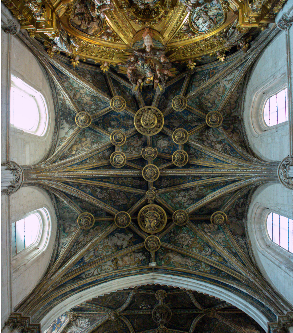
Conjunto de bóvedas de la capilla mayor
