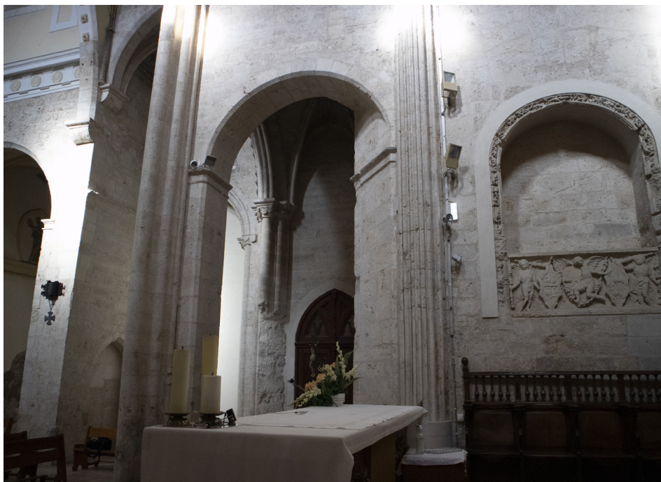
Detalle del paso al tramo bajo de la capilla mayor
