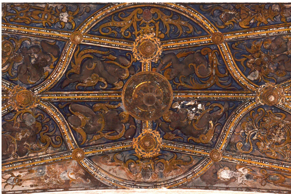
Detalle de la decoración del tercer tramo (bajo)
